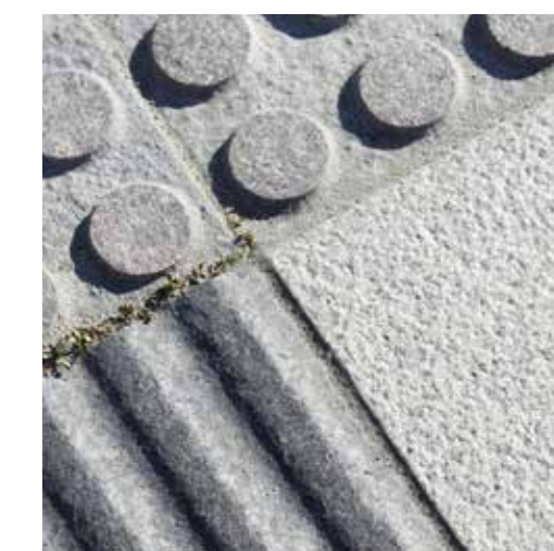
Ledstråk med sinusplattor av nordisk granit likt övrig beläggning. Foto: Naturstenskompagniet.
