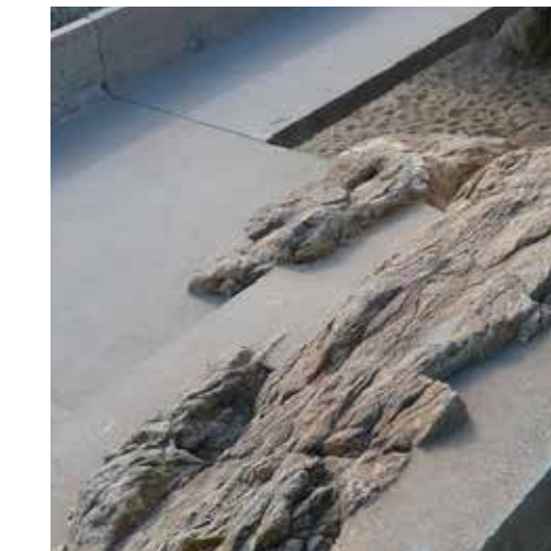
Naturstensblock placeras där stora höjdskillnader ska tas upp i slänterna. Stenarna bryter av det annars strikta formspråket och står i kontrast till de släta beläggningarna. Foto: Álvaro Siza Vieira, Leça Swimming Pools.
