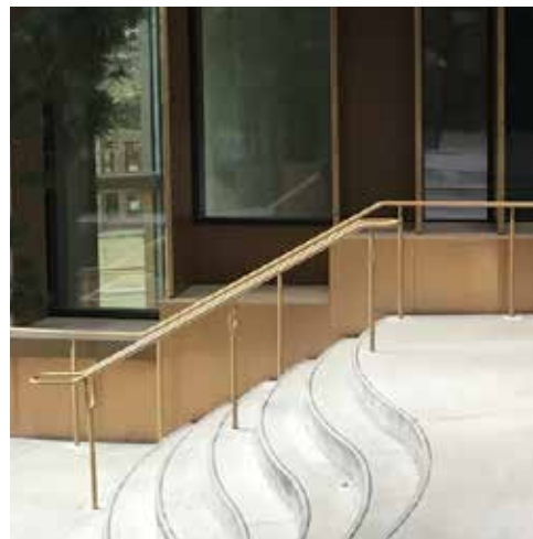
I trappor och ramper fungerar handledaren som ett naturligt ledstråk. Gestaltning av räcken ska samordnas med A. Foto: Holscher Design, City Dune Köpenhamn.
