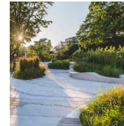
Cykelrampen, den tillgängliga rampen samt platsen framför stationsbyggnaden utförs i platsgjuten betong. Infälld kross markerar skillnad mellan gångytor och platsbildningar samtidigt som det bryter ned skalans och tillför ett taktilt element i beläggningen. Foto: AJ Landskap, Anders Franzéns park.
