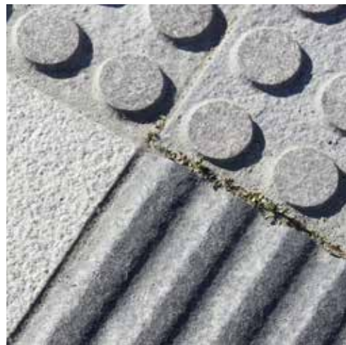
Sinusplattor i granit på busstorget. Bredd: 60 cm. Foto: Naturstenskompianiet.
