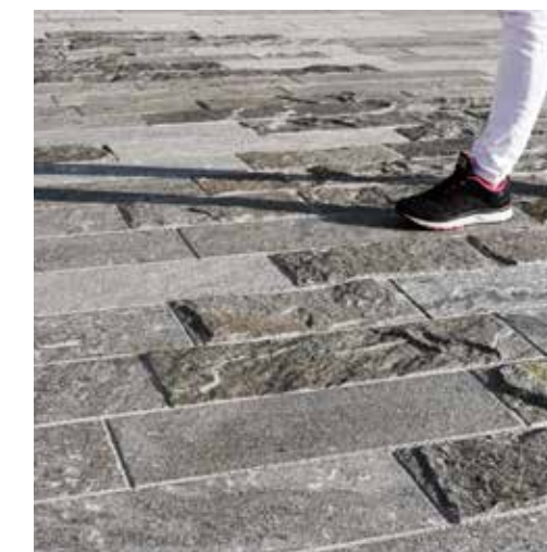
På bussterminalens mittersta del finns en gradient i beläggningen. Ju större flöden, ju slätare beläggning.
