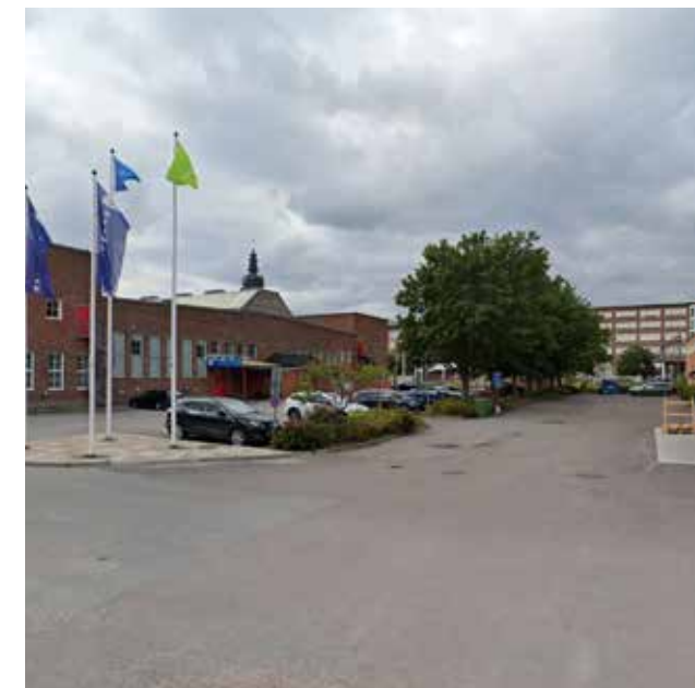
Det tillfälliga resecentrumet ska etableras i befintliga byggnader i kvarteret Sigurd 3. Här finns en möjlighet att skapa positiv uppmärksamhet kring projektet, samtidigt som platsen under byggtiden ska fungera som en effektiv stationsplats där alla känner sig välkomna.
