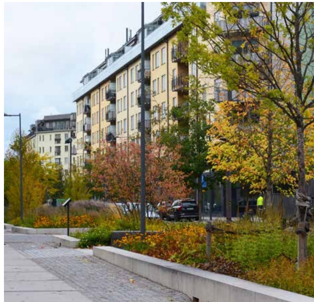
Exempel på dagvattenplantering i gatumiljö med inlopp för vatten i kantstenar. Foto: Hasse Wester, Norra Djurgårdsstaden.
