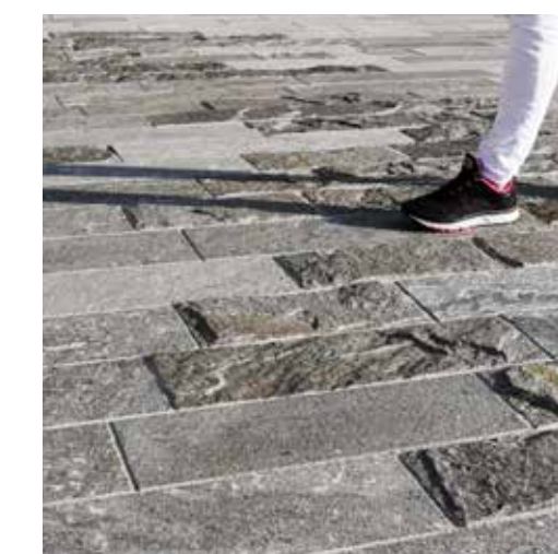
På järnvägstorget finns en gradient i beläggningen. Ju större flöden, desto slätare beläggning. Foto: Daniela Valentini, Meilen Town Hall.
